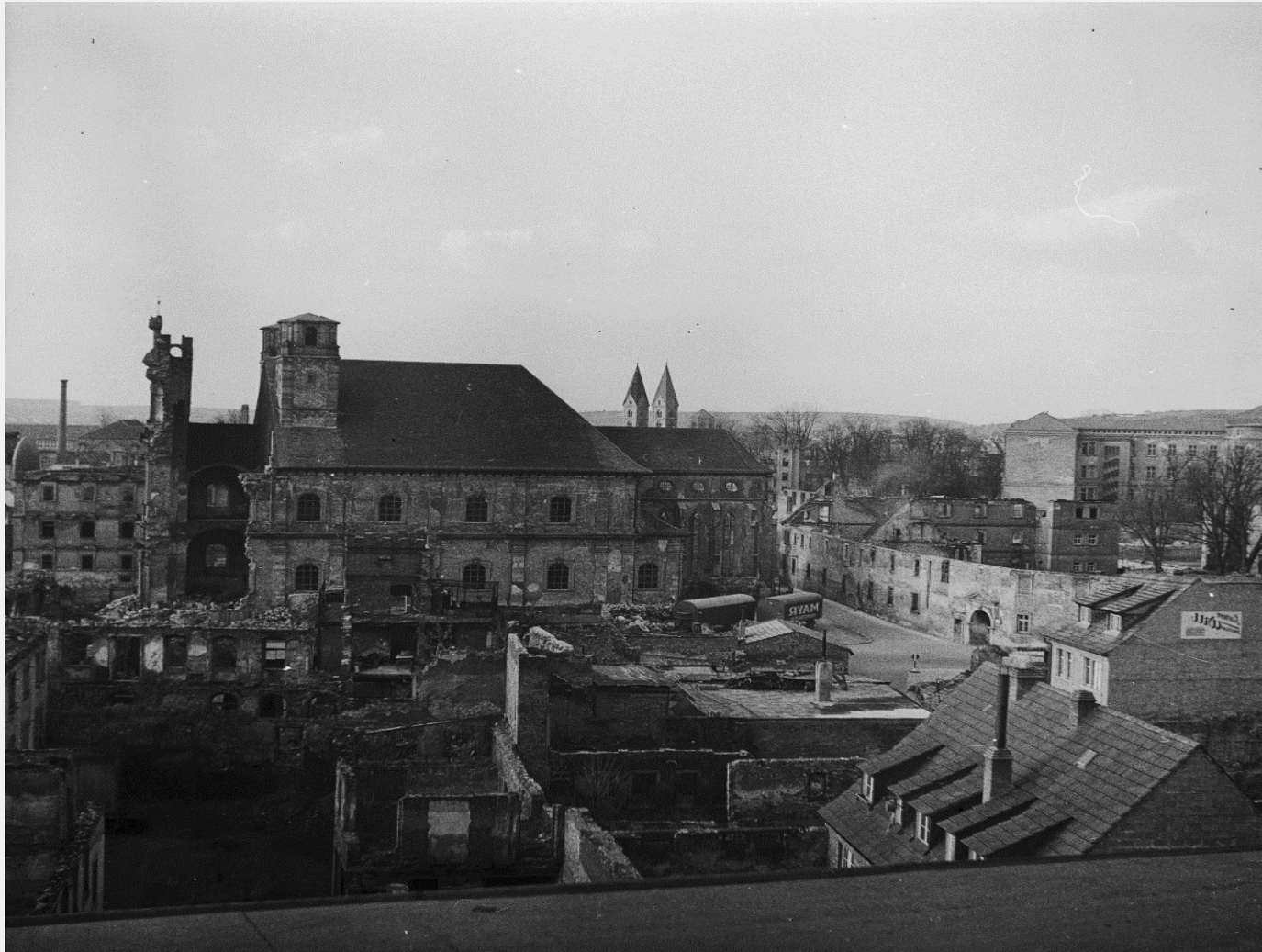
Zerstörungen im Umfeld des Peterplatzes
